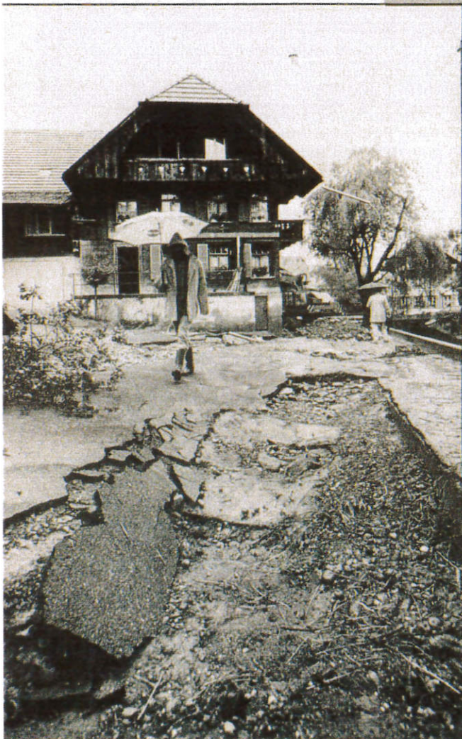
Schäden über Schäden.
